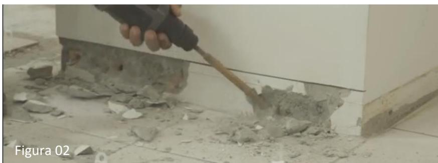
3 - Com a talhadeira retire os caroços da parede deixando o recorte o mais nivelado possível.
