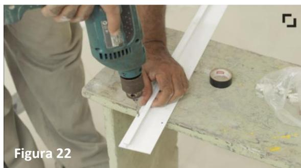
8 - Posicione os rodapés na parede para a marcação onde será realizado os furos das buchas e parafusos. Faça os furos na alvenaria, coloque as buchas, na sequência aplique um cordão de Super Adesivo Santa Luzia sinuoso e contínuo ao longo das costas da barra.
