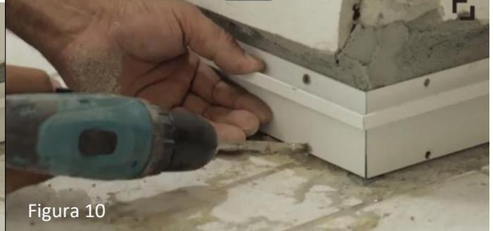
9 - Antes do acabamento, verificar o alinhamento do rodapé com o reboco existente. Com o auxílio de uma régua ou com as costas do gabarito produzido anteriormente. A parede deve estar nivelada com os pontos A e B do desenho abaixo. Vide figura 11.
