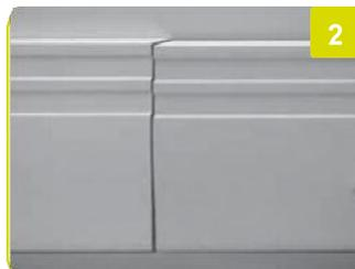
**13.** Al instalar las bases y contramarcos de Santa Luzia en una pared larga, se pueden unir varias barras. Para eso, cortar los extremos de las barras en un ángulo de 45° (ajustando el bisel), utilizando una sierra de inglete eléctrica con hoja de 96 dientes y 12 pulgadas de diámetro.
